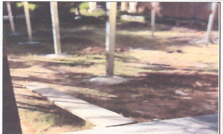
Foto 2: fundicion de Grada o rampa para bajar al area de usos multiples
