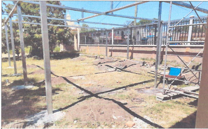
Foto 1: Mejoramiento en área de usos múltiples, ( fundición de piso torta de cemento en área de usos múltiples, ampliacion de galera)
